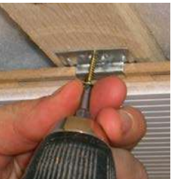
Befestigung mit Montagekrallen
